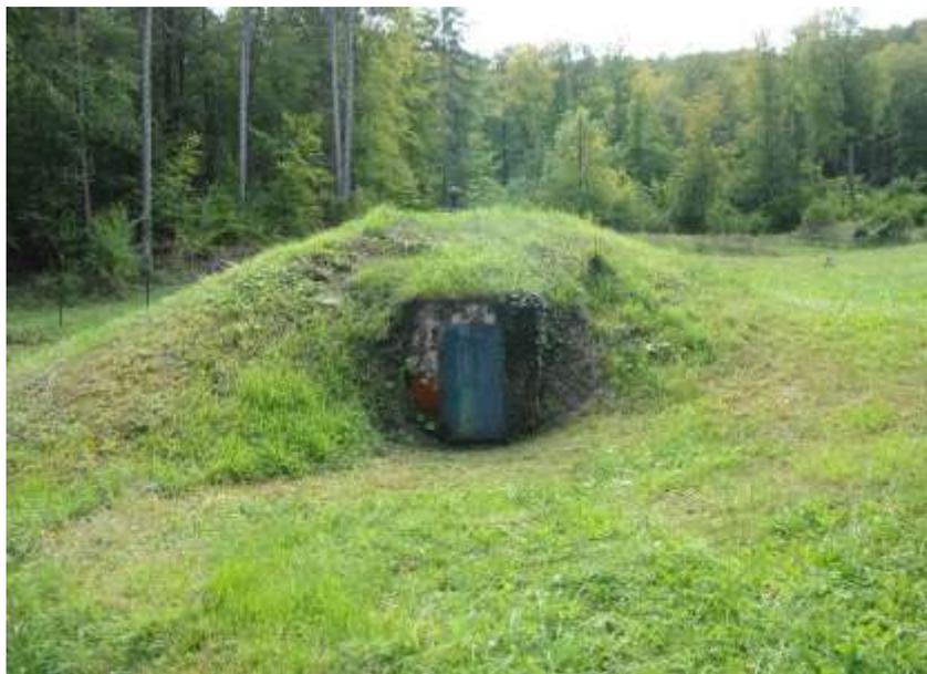
Le réservoir de 150 m<sup>3</sup> a été construit en haut de la rue de la Promenade à une altitude de 280 m, de façon à pouvoir être alimenté par gravité par les captages de la Grotte et de la Roche du Moutru et par pompe pour le Puits de la Croix de Cabaret.
