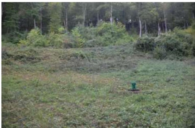
Les 5 sources situées à une altitude variant entre 300 et 320 m sont captées dans un regard en béton protégé par un capot en fonte muni d'une aération. L'eau est ensuite dirigée vers un réceptacle situé à 295 m surmonté d'un capot en fonte avec cheminée d'aération.
